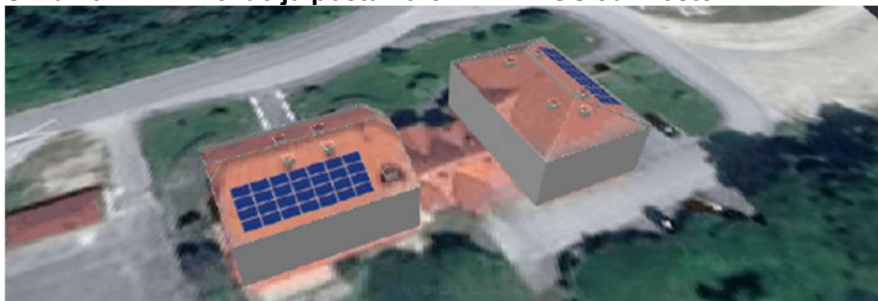
Slika 13: Lokacija postavitve FVE – POŠ Jurklošter
