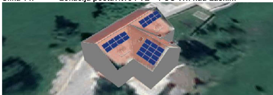
Slika 14: Lokacija postavitve FVE – POŠ Vrh nad Laškim
