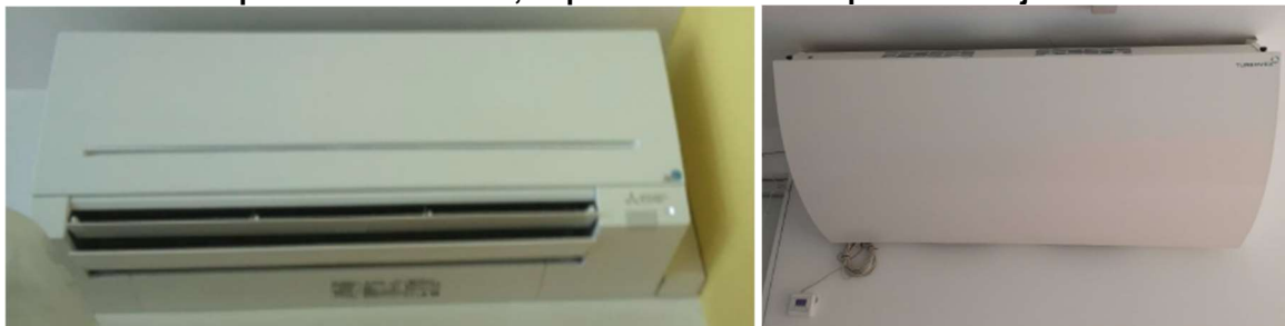
Slika 9: Split klimatska enota, naprava za mehansko prezračevanje
