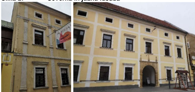
Slika 2: Severna in južna fasada
