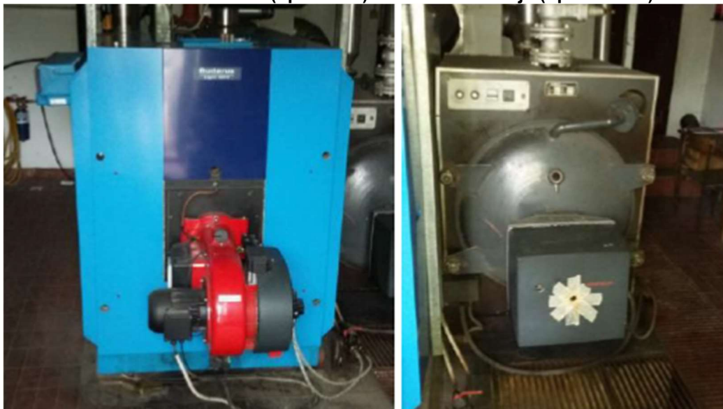
Slika 4: Kotel Buderus (tip GE615) in kotel Emo Celje (tip SVN 200)
