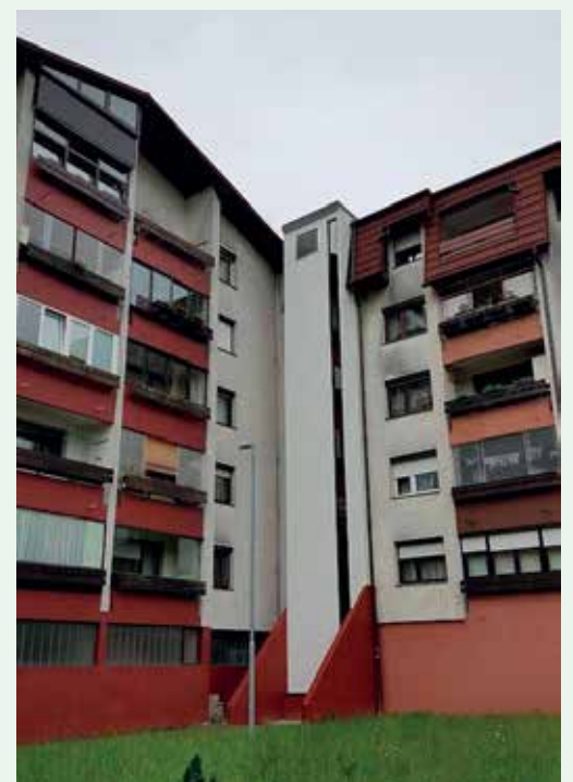
Zunanji izgled objekta, Badovinčeva 16
