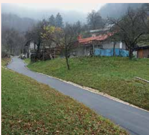
Tak je pogled s spodnje strani na nov asfalt v Rifengozdu od Sajovica proti Hriberškovim.
